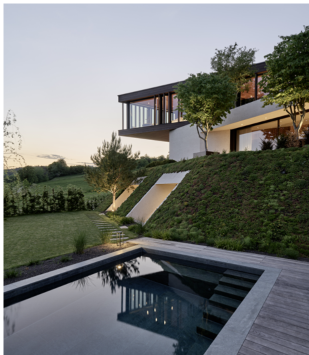
Weil das unterste Volumen im Gelände verankert ist, entwickeln die Unterhaltungsräume im Inneren sowie der Garten, der Swimmingpool und die vorhandenen Bäume im Außenbereich eine natürliche Synergie. (Foto: Zooney Braun)
